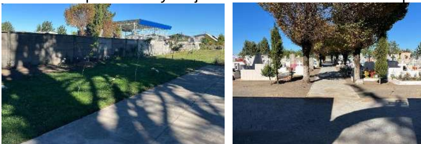
23.- Construcción cierre perimetral y mejoramiento cementerio Municipal de Tucapel.
