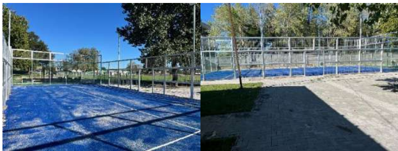
26.- Construcción cancha de Pádel, estadio de Tucapel.
