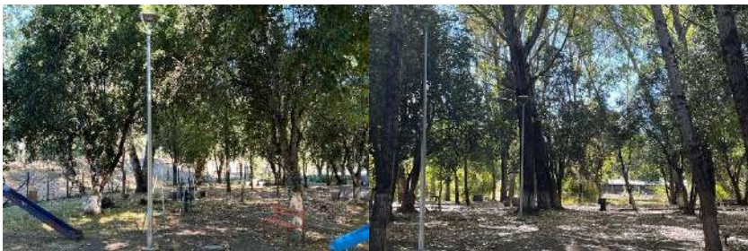
31.- Construcción iluminación balneario municipal, comuna Tucapel.
