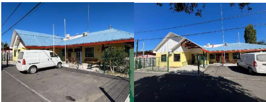
28.- Reparación infraestructura Posta salud Rural Polcura, comuna Tucapel.
