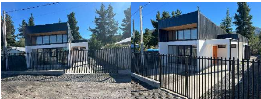
27.- Construcción sede social Piedra Azul de Polcura, comuna de Tucapel.
