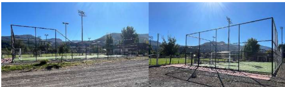
24.- Construcción cancha Los Laureles, Polcura, comuna de Tucapel.
