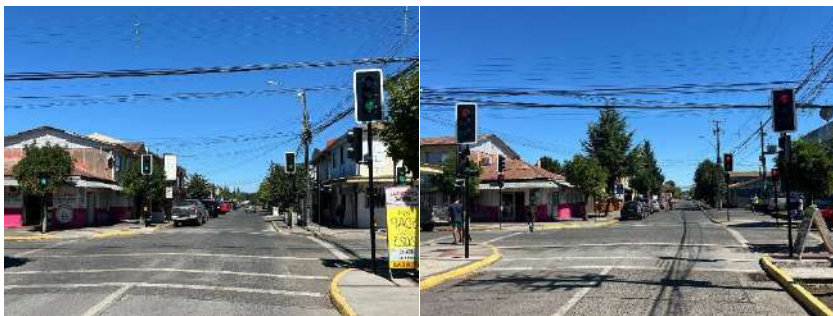
22.- Construcción semáforo intersección calle 12 de febrero esquina Arturo Prat de Huépil, comuna de Tucapel.
