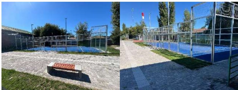
25.- Construcción cancha de Pádel, estadio Bicentenario de Huépil.
