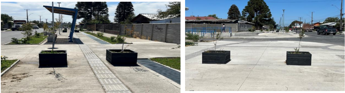
38.- Adquisición e Instalación de maceteros urbanos y arbolado localidad de Huépil.
