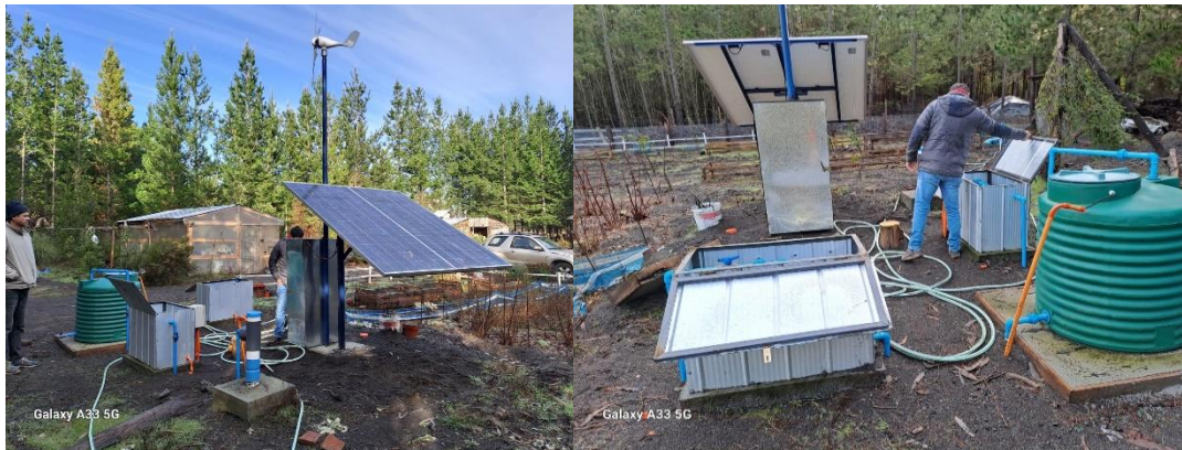
26.- Construcción plaza activa Villa Cordillera de Huépil, comuna de Tucapel.
