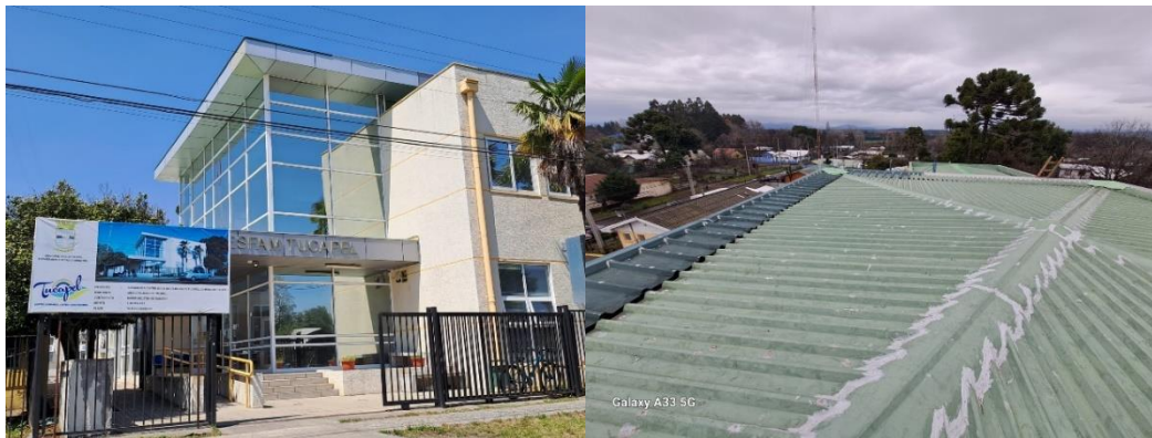
35.- Mejoramiento Cubierta Cesfam.
