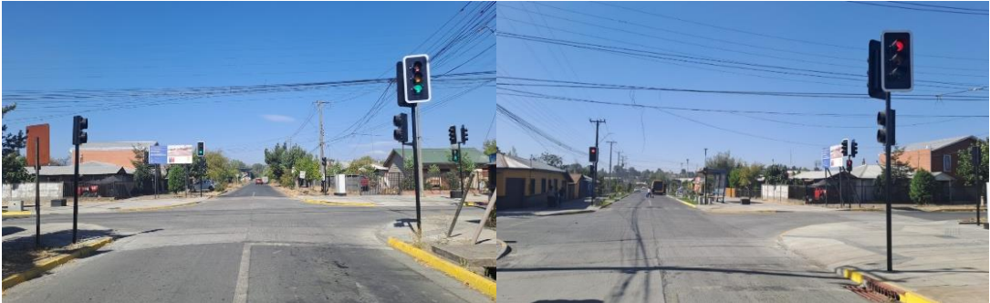
41.- Construcción semáforo intersección de Av. Tucapel con Irrrazabal de Huépil, comuna de Tucapel.
