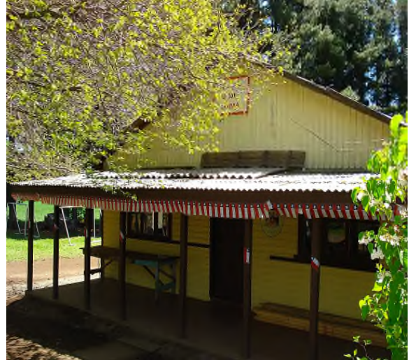
ESCUELA G-1017, LA OBRA
